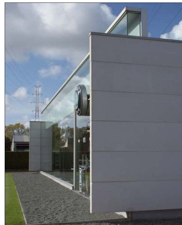
Voor de bouw van een garage – een freelanceproject voor Architectenburo APS – paste Vandenbogaerde panelen in cellenbeton toe, geplaatst op een staalskelet
